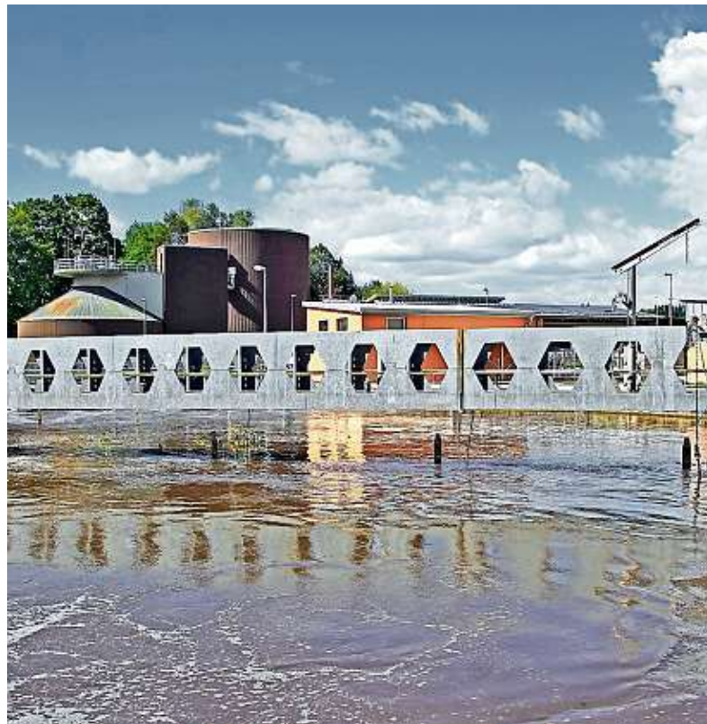
Das Klärwerk im Kämpfelbachtal filtert das Abwasser, wobei Klärschlamm entsteht, der dann aus Gründen des Umweltschutzes verbrannt wird. ARCHIVFOTO: ROLLER
