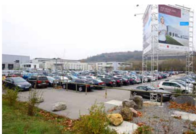
Unter dem rechten hinteren Bereich dieses Parkplatzes im Steiner Gewerbegebiet „Mittelaltal“ liegt das Regenüberlaufbecken RÜB 9 des Abwasserverbandes. Die Überbauung mit einem Parkhaus kann aus technischen Gründen nicht zugelassen werden.
