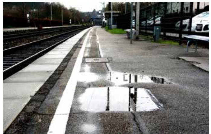
Bahnsteig Richtung Pforzheim vor barrierefreiem Umbau
