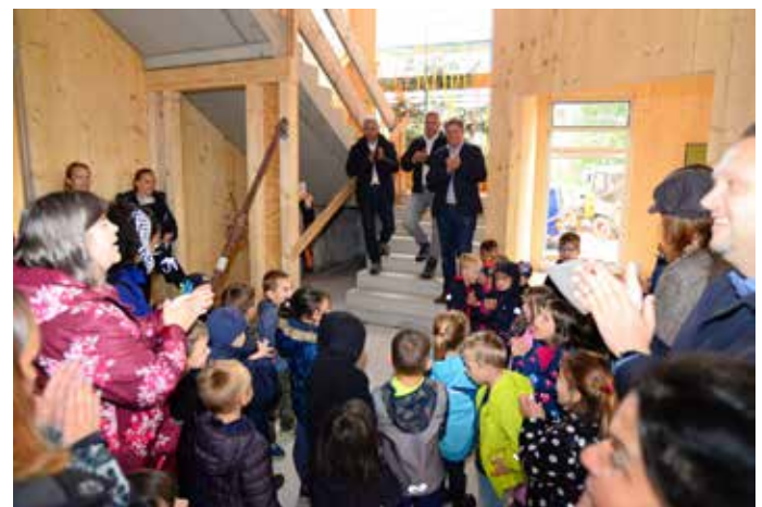
Tag der Freude war das Richtfest für die neue Kindertagesstätte. Beim Richtspruch im trockenen Treppenhaus Architekt Ulrich Homfeld, Geschäftsführer Matthias Laube und Bürgermeister Thomas Zeilmeier (von links)
