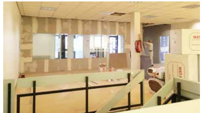
Der Countdown läuft: Die Führerscheinstelle zieht bald in das Gebäude Am Mühlkanal 3a im Brötzingertal. Die Vorarbeiten dort laufen auf Hochtouren. (enz)
