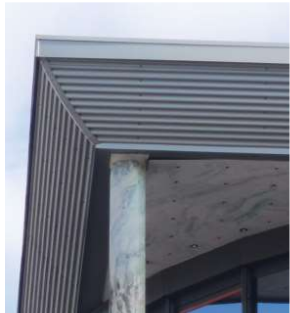
Gebäude am Rothenrain mit Zugang unter die Deckenverkleidung
